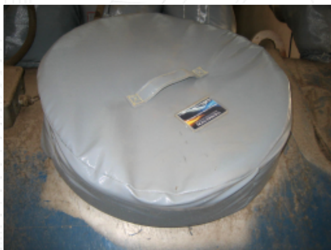
ISOLATION DE TRAPPE D'ACCÈS SUR CUVE
