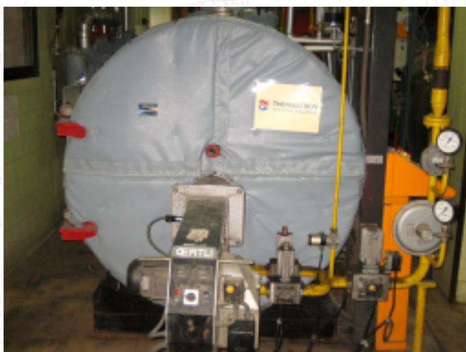
ISOLATION DE FAÇADE DE CHAUDIÈRE
