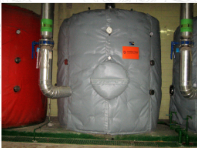
ISOLATION DE CUVE
